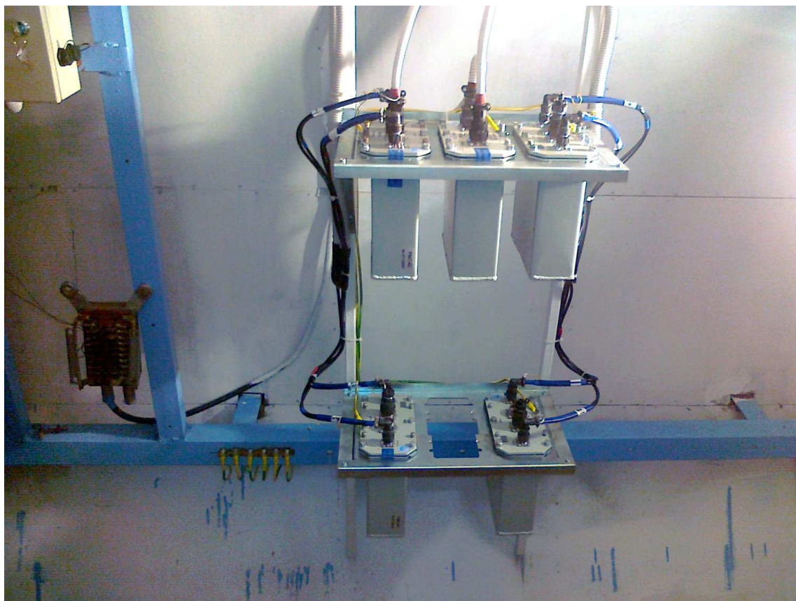
Рисунок 6. Пример монтажа блока ВК-01 в каркас с регенераторами РМС-42
